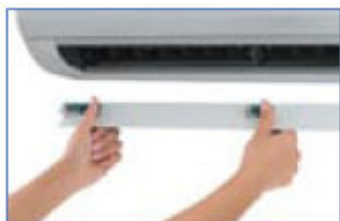
Po otwarciu kratki uzyskamy dostęp do wentylatora.
