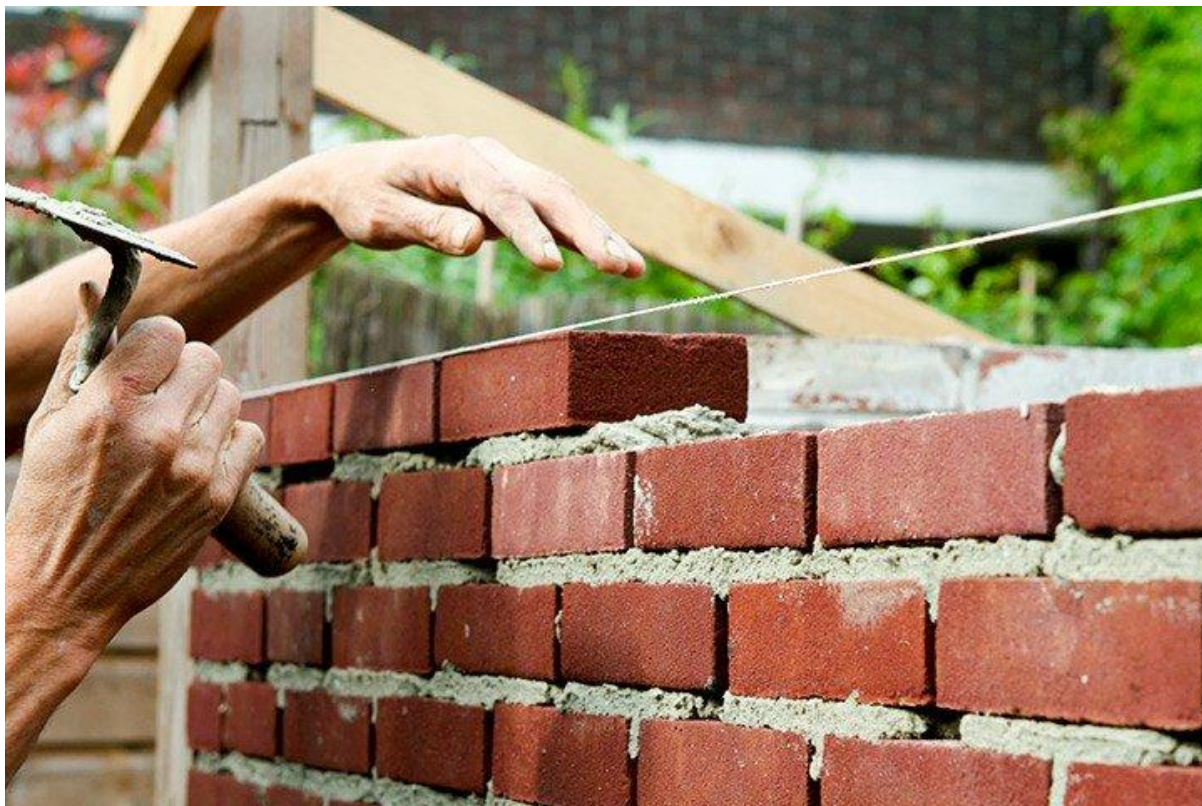
Budowa altany murowanej
