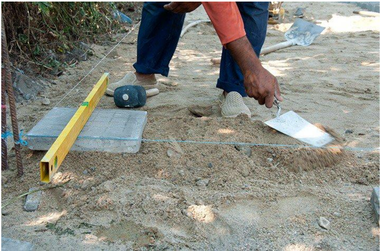
Budowa altanki krok po kroku - fundamenty
