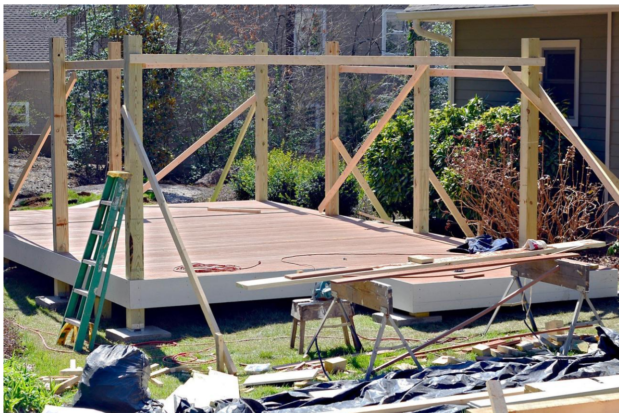
Budowa altany krok po kroku
