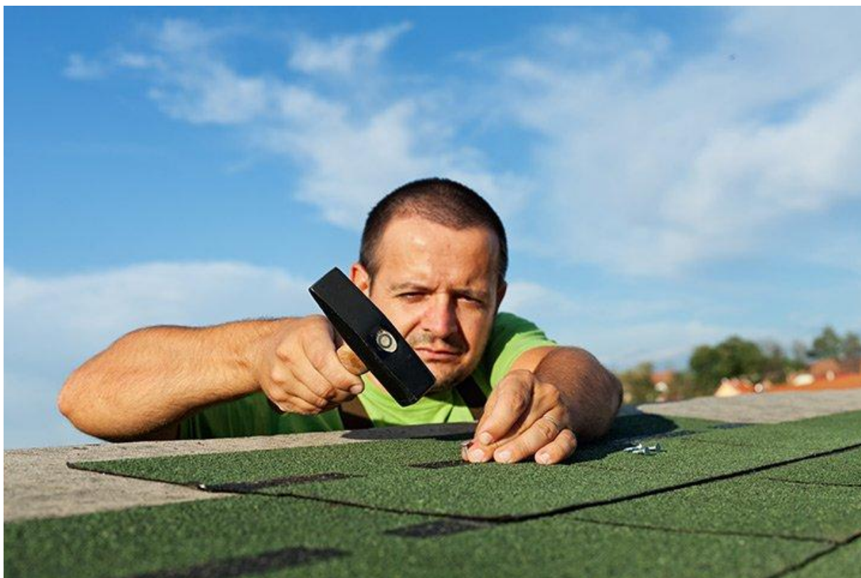
Budowa altany dach
