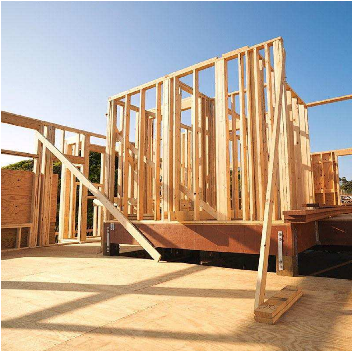
Konstrukcja drewnianego domu
