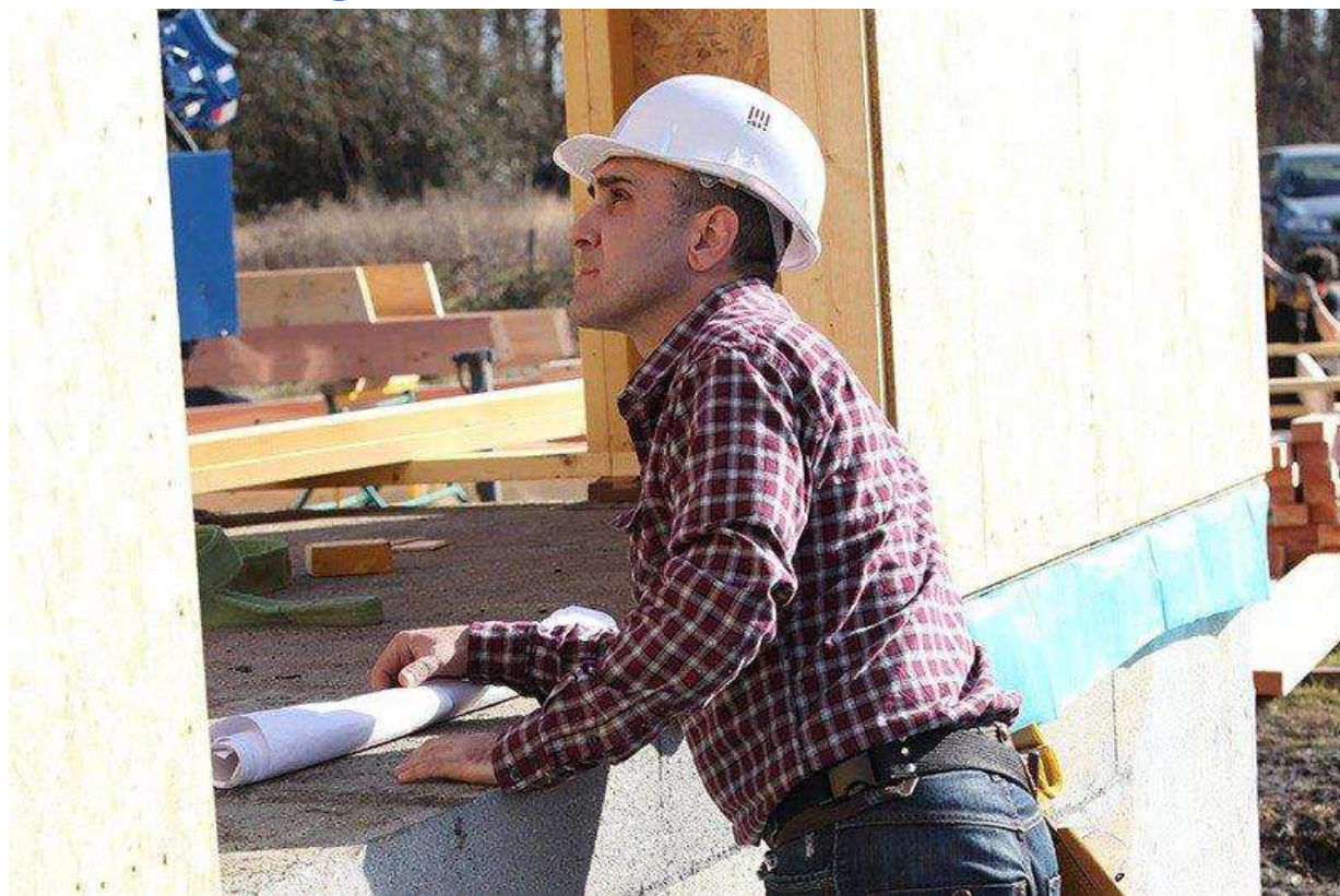
Montaż drewnianego domu
