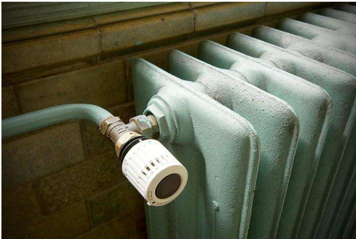
Adaptacja starego domu na energooszczędny
