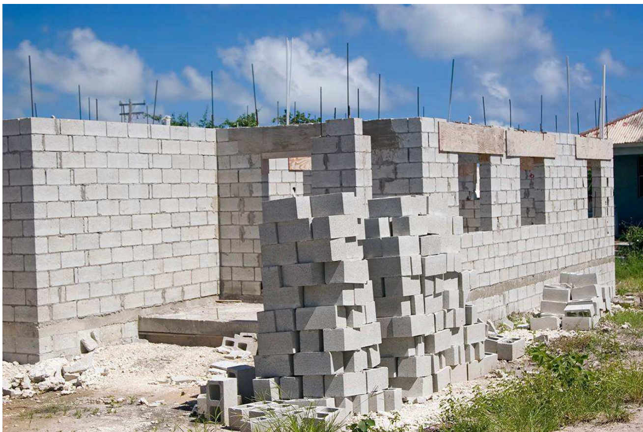
Stan surowy otwarty - murowanie ścian
