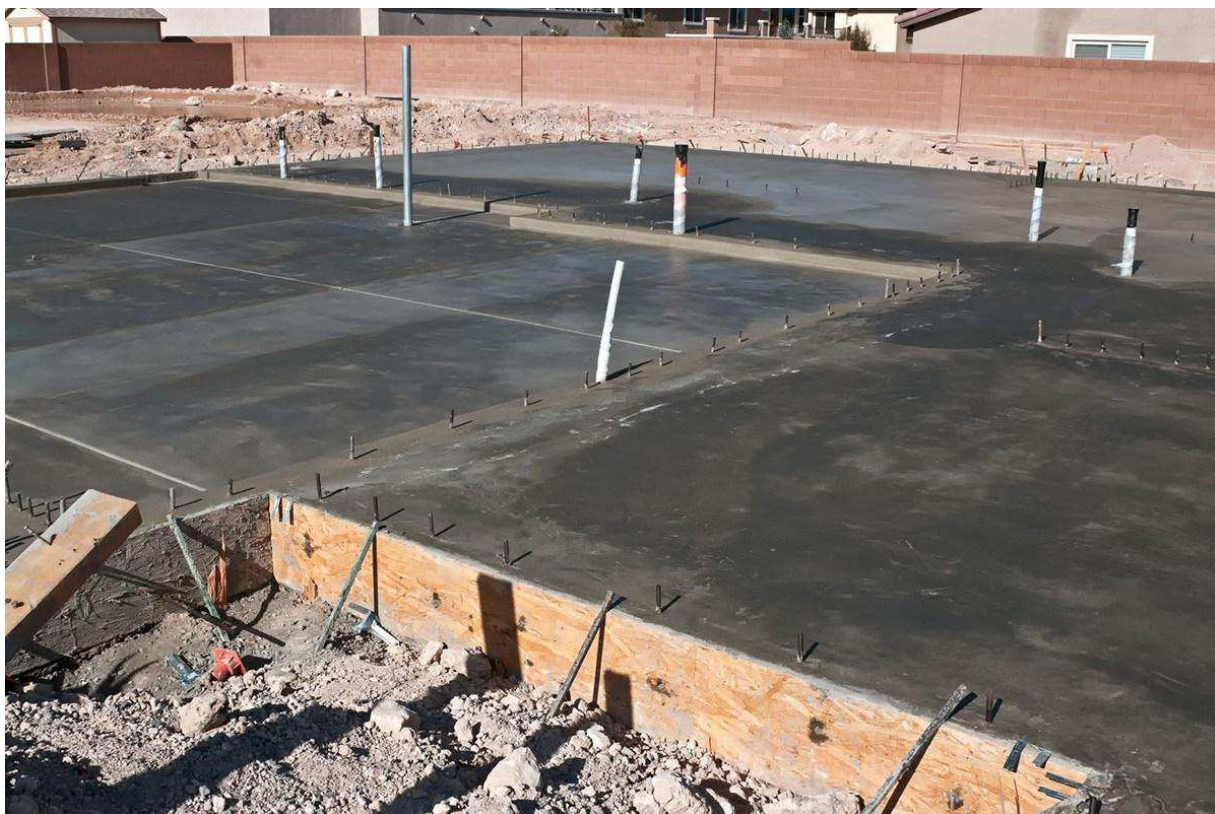
Stan zero roboty ziemne i fundamentowe
