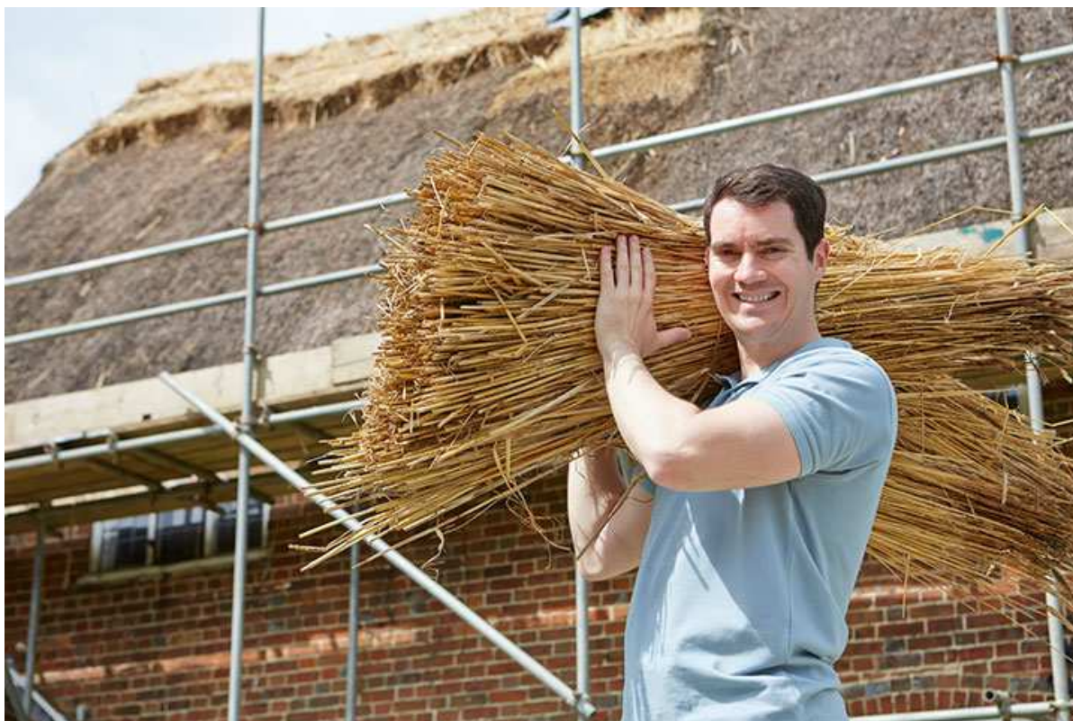
Dach z trzciny
